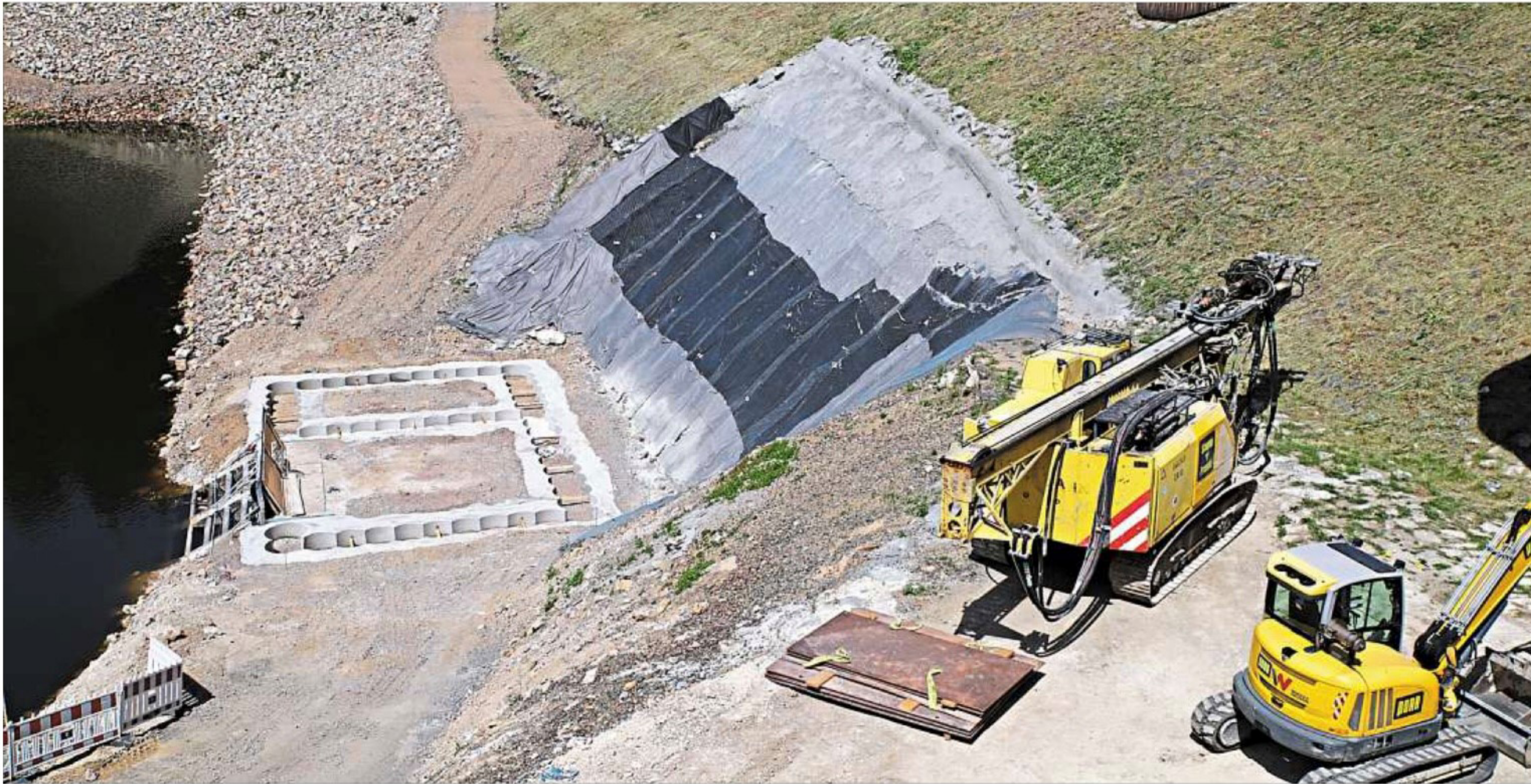
Seit Anfang des Jahres wird am Staudamm des Eixendorfer Sees gearbeitet. Entstehen soll ein Oberflächenwasser-Entnahmeturm.
