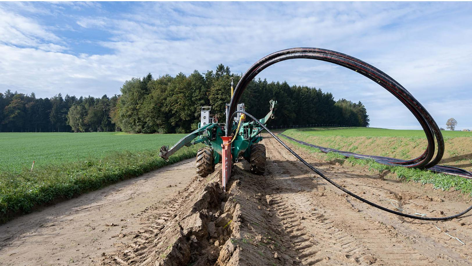
Künftig kann in Tann und Reut mehr erneuerbare Energie aufgenommen und verteilt werden. Mit dem Kabelpflug wurden Leerrohre für die künftige Kabelleitung in die Erde eingebracht.
