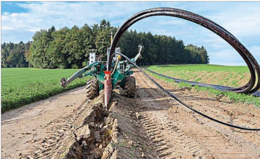
Künftig kann in Tann und Reut mehr erneuerbare Energie aufgenommen und verteilt werden. Mit dem Kabelpflug wurden Leerrohre für die künftige Kabelleitung in die Erde eingebracht. – Foto: Bayernwerk
