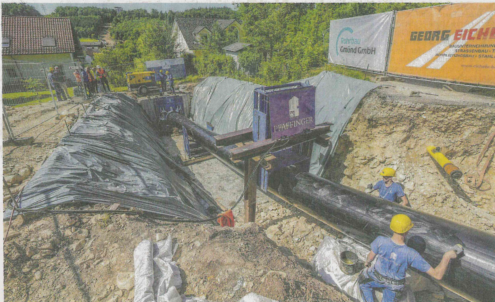
Mittels des Inliner-Verfahrens wird ein neues PE-Rohr auf einer Länge von 350 Metern durch das marode Grauguss-Rohr gezogen. Foto: Rudi Penk
