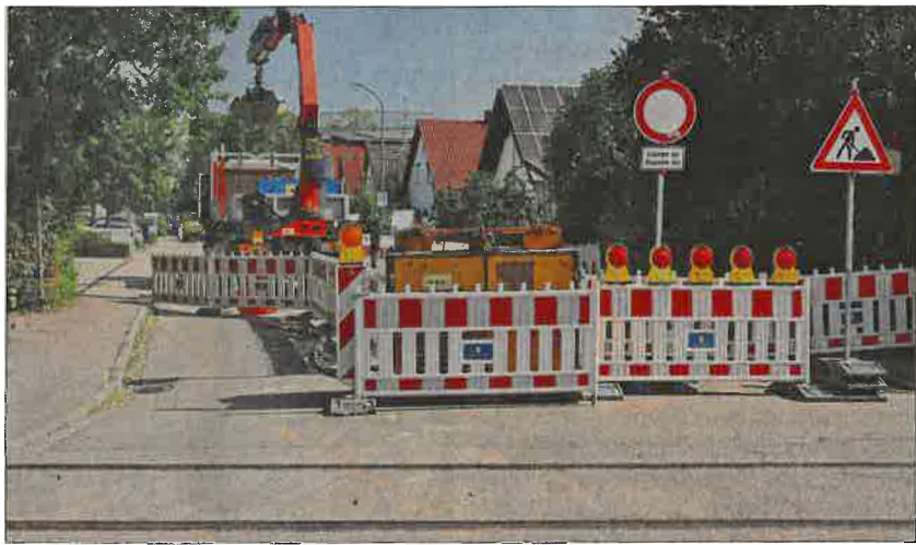
Unter den Gleisen im Bereich Industriestraße/Albinstraße wird zunächst ein Schutzrohr verlegt, in dieses kommt dann die Gasleitung hinein. Foto: Josef Fuchs
