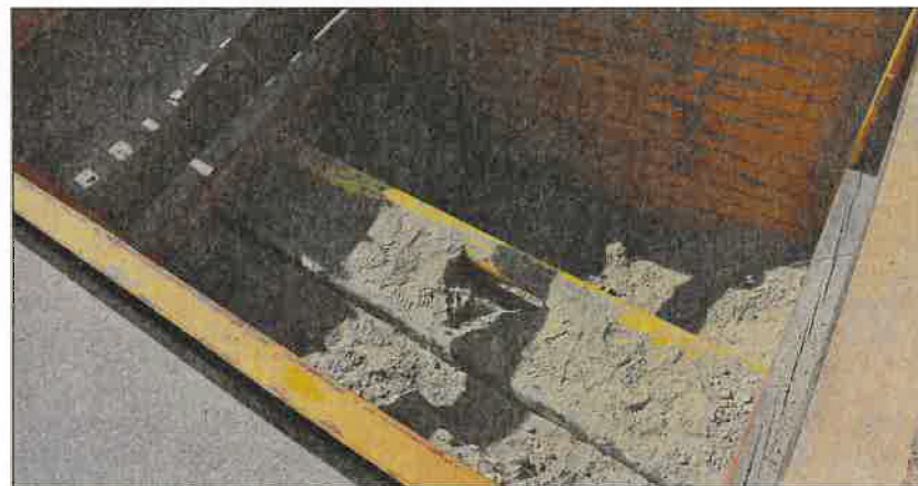
Im Aushub in der Straßenmitte wird das schwarze Rohr abgezweigt werden.
