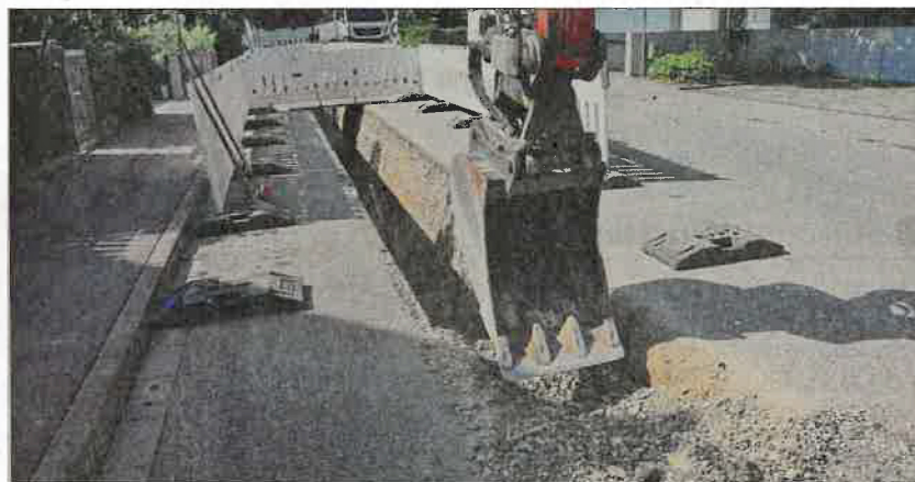
In der Albinstraße wird die neue Trasse bereits ausgehoben.
