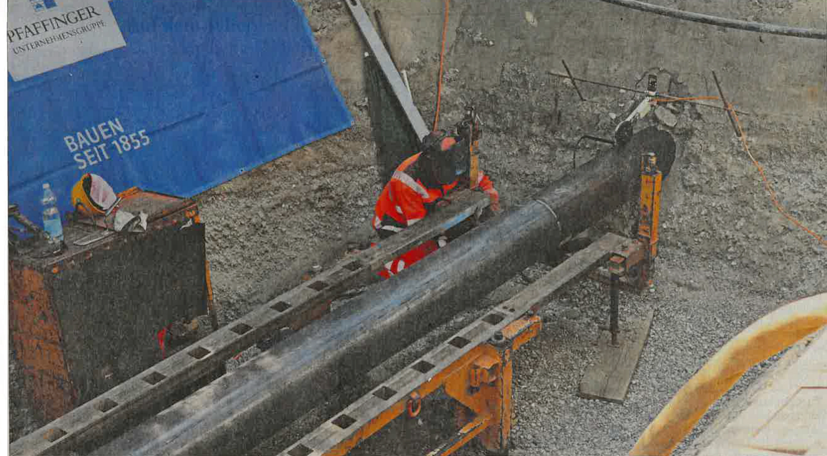
Von der Albinstraße her wird ein 14 Meter langes Schutzrohr mittels eines Räumbohrers unter die Schienen geschoben, bis es beim Aushub in der Mitte der Industriestraße knapp unterhalb der bestehenden Hochdruckleitung ankommt. Danach wird die eigentliche Gasleitung aus Stahl eingeführt. Fotos: Josef Fuchs
