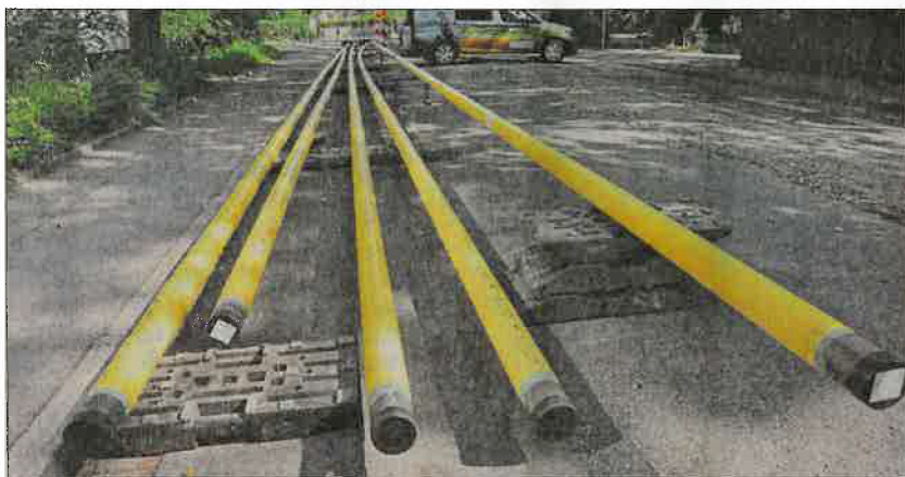
Die eigentlichen Gasrohre liegen schon bereit.
