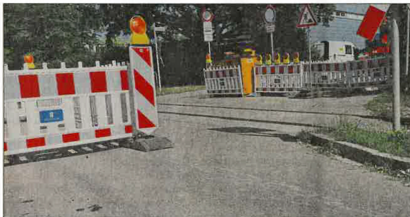
Von der Grube rechts unter den Gleisen in den Aushub in der Industriestraße.
